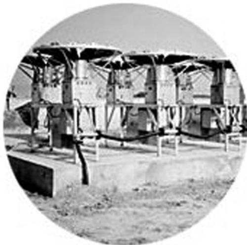
图 4 用于天然气管道监控、数据采集、通讯和阴极保护的温差发电装置
