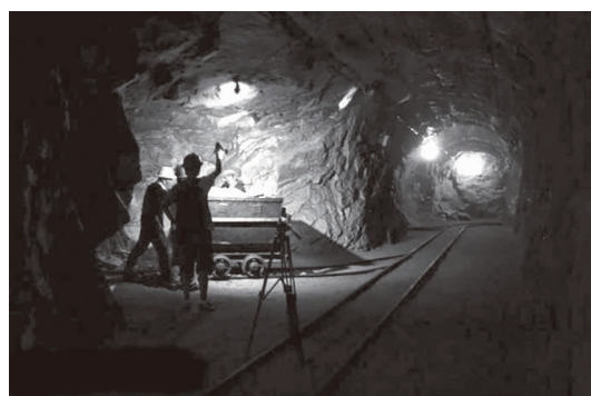
图5 唐口煤矿井下巷道爆破
