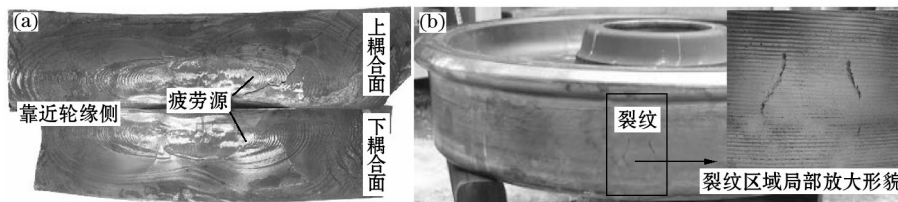
(a) CRH1 动车组用 ER9 车轮辋裂; (b) CRH2A 动车组用 SSW-Q3R 车轮剥离裂纹。
