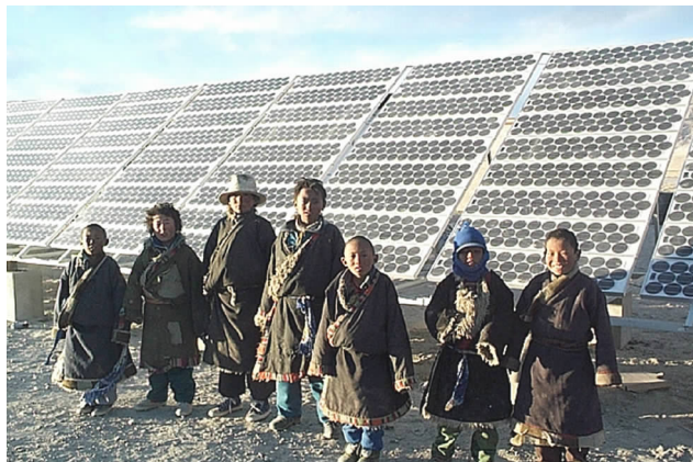
西藏光伏村庄供电系统
