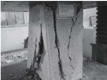
(a) 基准配比混凝土
