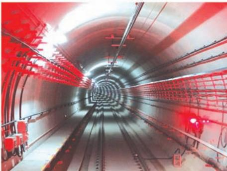
(b) 刚性接触网照片
