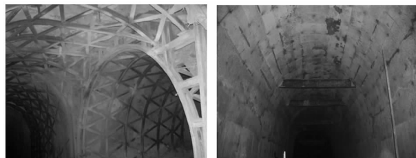
(a) 桁架支护 (b) 永久支护后的泵房
