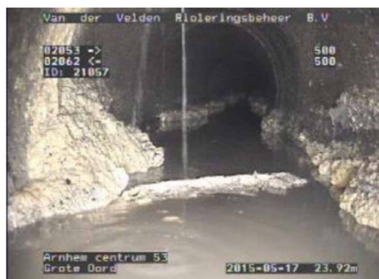
图 1 排水管道中的 FOG 沉积物 [14]
