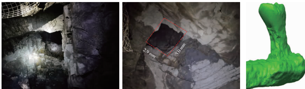
图 10 爆破成井效果及三维扫描情况
