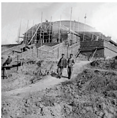
图1 20世纪50年代半坡遗址大厅建设工地
