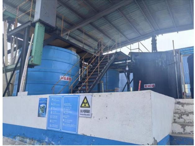
图 2 某伴生放射性废水处理设施-初步反应罐
