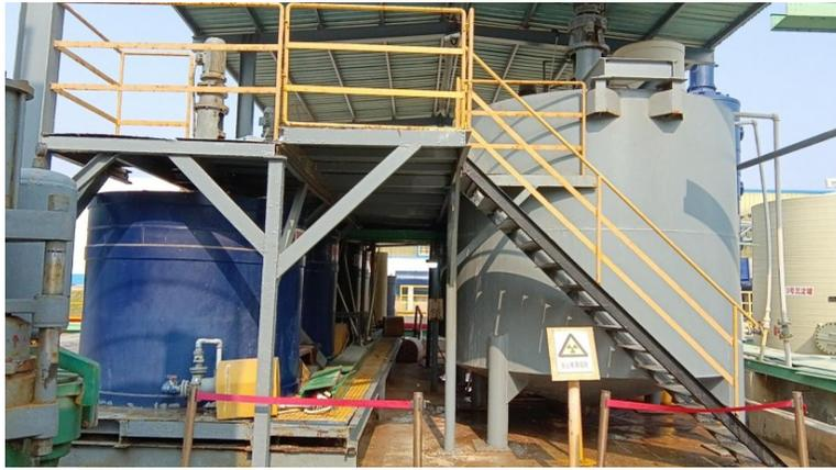
图4 某伴生放射性废水处理设施-深度反应罐
