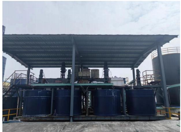
图 3 某伴生放射性废水处理设施-配药剂罐
