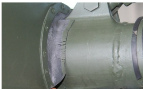
图12 密封橡胶龟裂 Fig. 12 Sealing rubber crack
