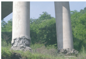
图 1 墩底弯曲型破坏
