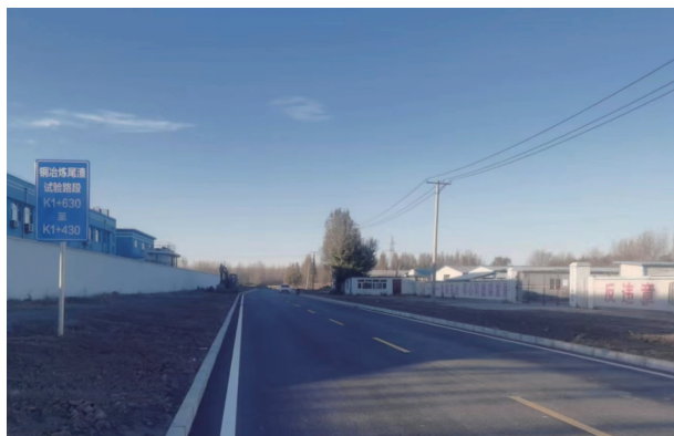
图2 铜冶炼渣应用于路基材料现场照片
