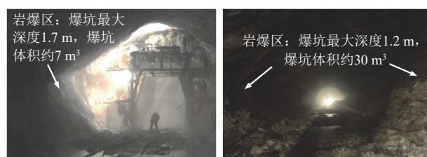
图 3 破坏规模显著差异的 2 个强烈岩爆案例
