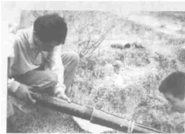
图1 施工中的输卤水玻璃钢管线
