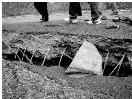
图4 路基开裂破坏
