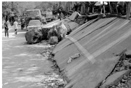
图2 路基结构间接破坏
