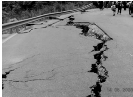
图1 路基结构直接破坏
