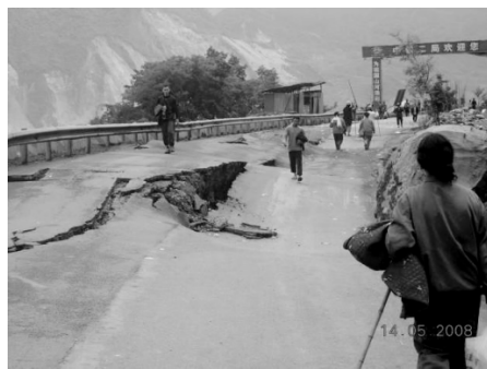
图3 路基沉陷变形破坏
