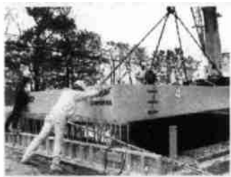
图 7 Hardcore 夹芯桥面板的组装
