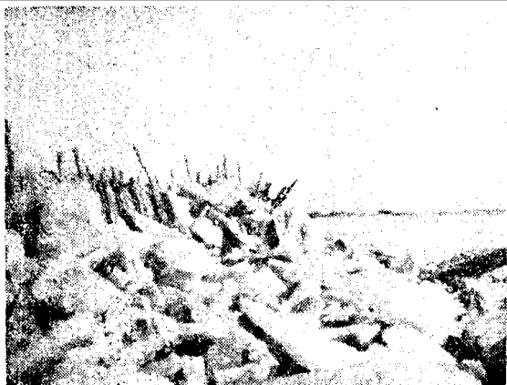
圖一 四千餘萬立方公尺的積冰,積滿了四十多華里的黃河河道,巨大體積的冰塊,爬上了稽壩、堤頂,造成黃河決口前的嚴重形勢。
