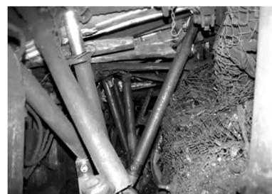
图 1 强矿压显现下巷道支护破坏严重情况
