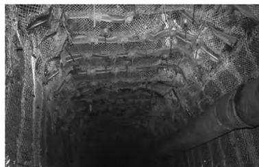
图 3 顶板变更支护后效果
