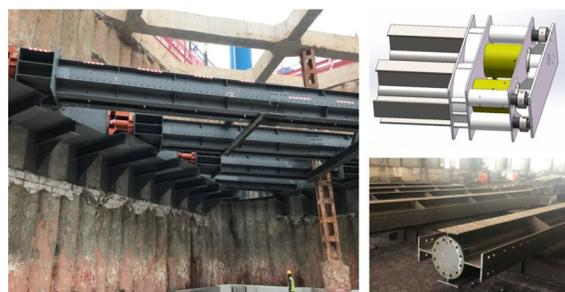
图4 钢管混凝土+T型钢组合结构
