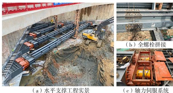
图10 水平支撑体系施工实景
