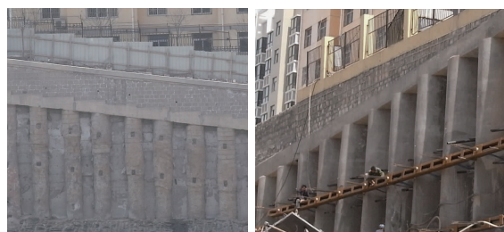
(a) 西侧桩锚整体式支护
