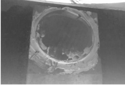
图5 刃脚土压力传感器安装
