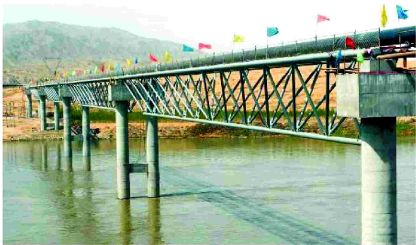
图 1 竣工后的西气东输中卫黄河跨越工程图
