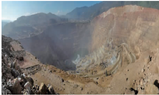
图 2 露天采场全貌 Fig. 2 Overview of open pit slope
