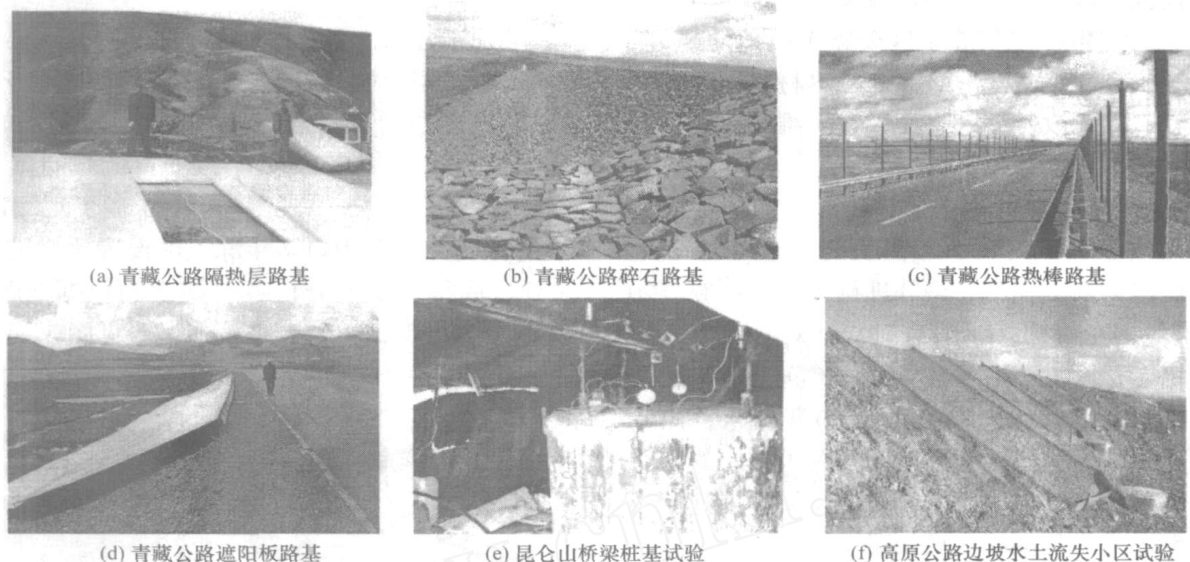
图5 实体试验工程
