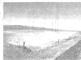
图4 青藏公路路基模型 现场试验工程
