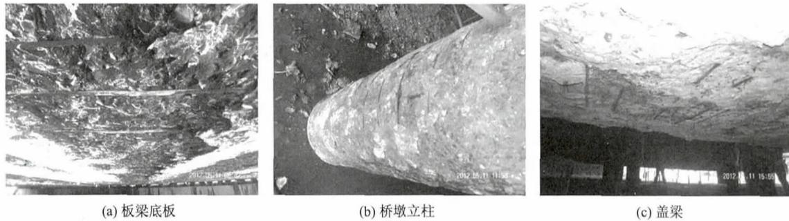
图1 混凝土剥落、钢筋外露
