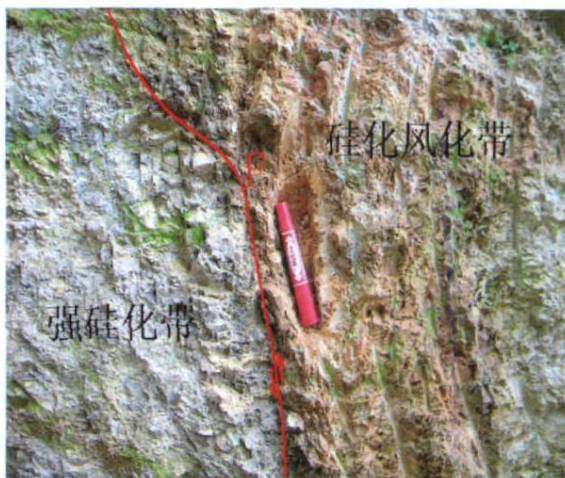
照片6 硅化带中的构造分带(天柱风溪) (黎平水口金坑)
