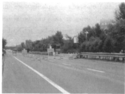
图2 半幅封闭施工区现场概况
