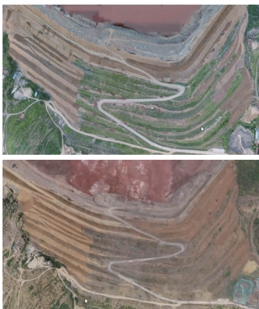
图 2 2019 年 8 月(左)和 2020 年 6 月(右)尾矿坝点云模型 Fig. 2 Tailings dam point cloud models in August 2019(left) and June 2020(right)
