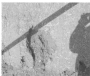
图8 降雨后植被纤维防护的坡面
