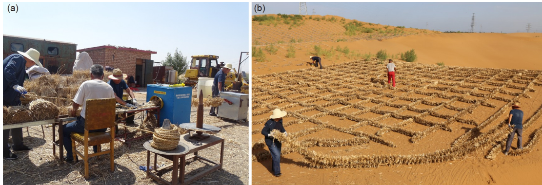
图2 (网络版彩图) (a) 刷状草绳机织生产现场; (b) 刷状草方格固沙障铺设过程
