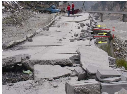
图 13 地表破裂复杂性示意图
