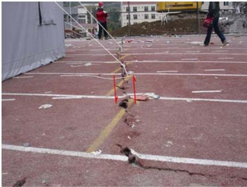
图6 北川中学操场 NNW 向左旋剪切破裂
