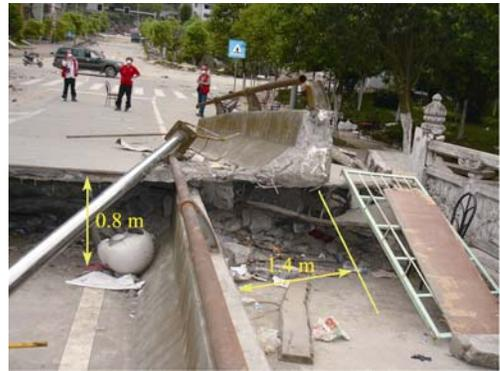
图7 北川大桥逆冲抬升 0.8 m, 假右旋走滑位移 1.4 m
