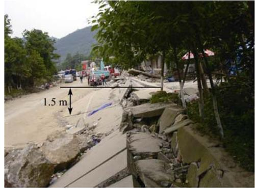
图5 北川中学北公路挤压破碎带, 垂直位移 1.5 m, 水平缩短 1.0 m
