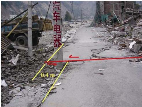
图 10 映秀镇形变带上盘抬升 1.6 m, 地表破裂左旋位移 0.4 m
