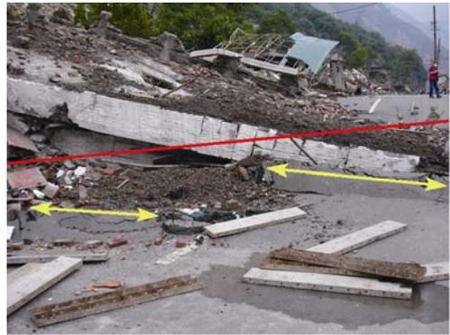
图 11 映秀镇地表挤压隆起鼓包雁列分布指示主破裂兼左旋走滑运动性质
