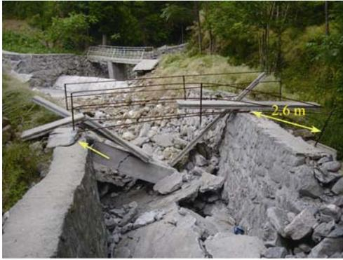
图4 北川县城后挤压破碎带沟宽相对于桥板缩短 2.6 m, 桥座发生顺时针旋转(箭头所示)
