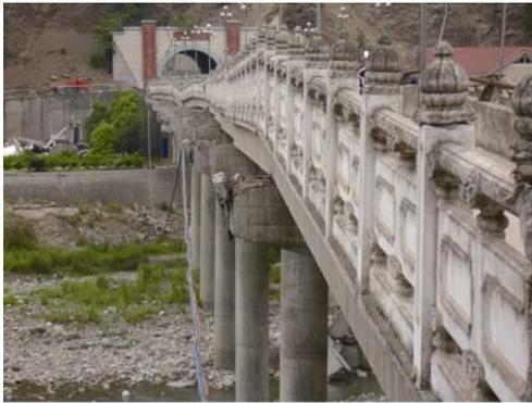
图8 北川大桥桥面向 NE 滑移而桥墩未错动
