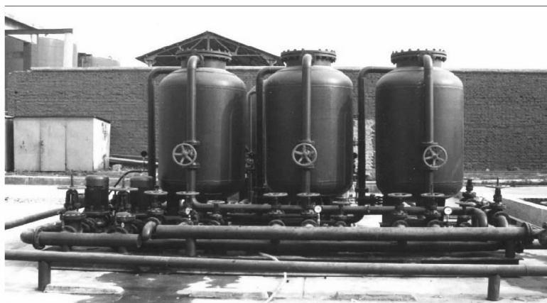
图6 过滤撬结构图
