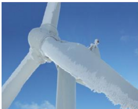
图 1 风力机叶片结冰 Fig.1. Wind turbine blade icing
