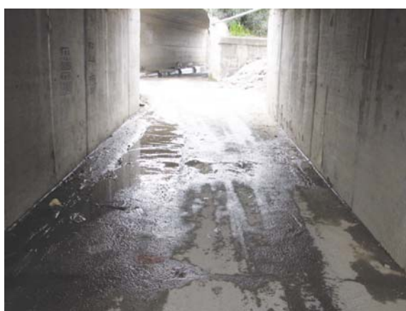
图4 没有排水道的地下通道遇大暴雨时会积水
