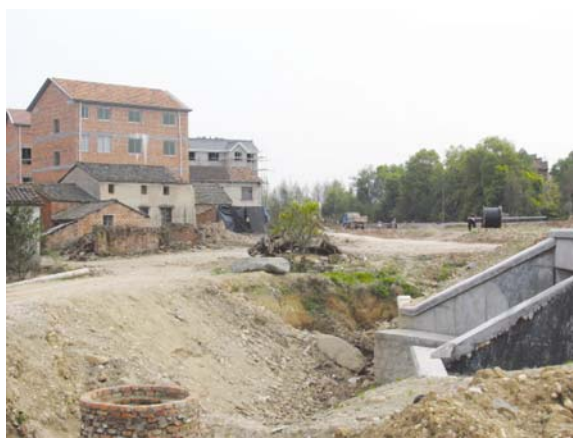
图 2 用以弥补原有道路被中断的下穿地道
