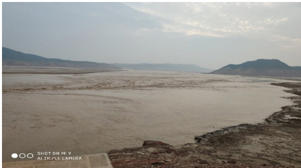
图3 (网络版彩图) 2020年7月23日小浪底水库跌坎在HH3断面处
