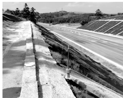
图1 坡面DCP测试
