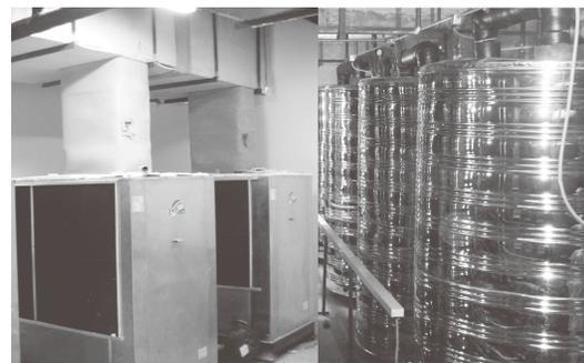
图3 热泵机组及热水储存罐实地安装照片
