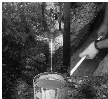
图5 广乐高速LK0+600左铎顶位移计安装
