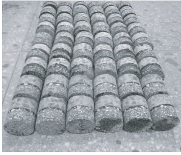
图5 脱模后的芯样
