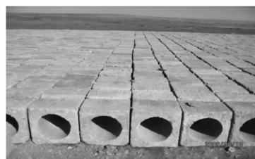
图 11 试验路中设置的预制块架空层
