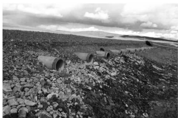
图 9 共和至玉树公路上的通风管路基
