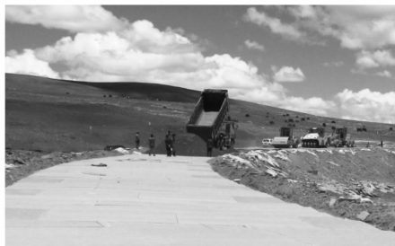
图1 XPS板隔热层路基现场施工情况
