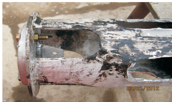
图6 改造后的内伸缩管
