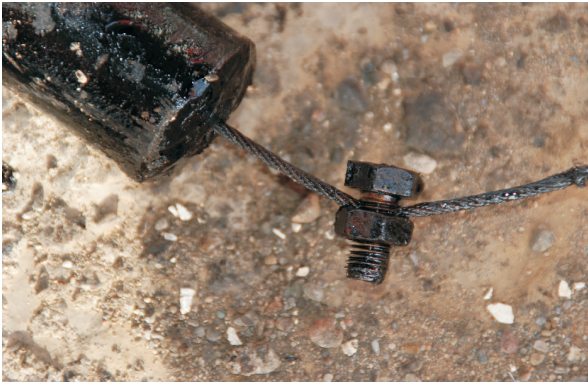
图 4 改造前钢丝固定方式
