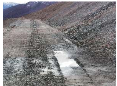
图6 白格滑坡后缘削方区第4级马道(高程3 702.0 m)散浸点
