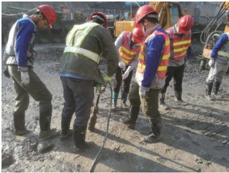
图 3 光纤埋设施工 Fig. 3 Embedding construction of optical fiber
