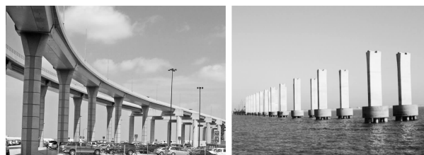
(a) 美国达拉斯机场高架桥
