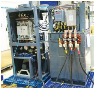
图 11 列车供电系统温升试验现场
