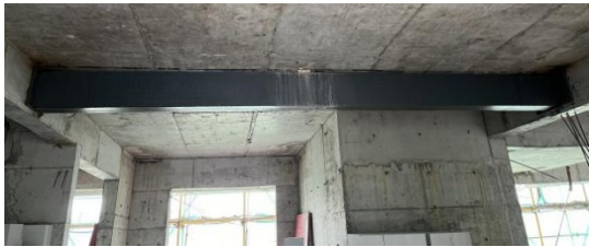
图 2 型钢梁加固楼板现场
