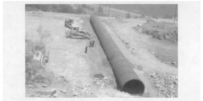
图 1 波纹钢板管涵结构整体图
