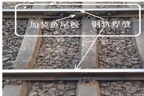
图 7 安装鱼尾板的钢轨(郭晋龙提供)
