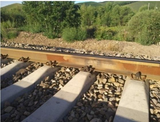
图 9 使用正火设备和工艺焊后的钢轨(郭晋龙提供)
